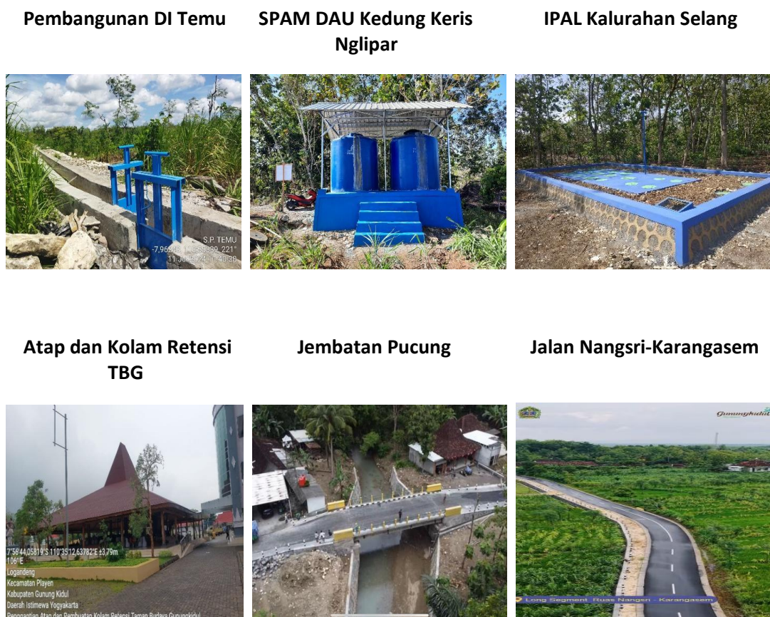
Gambar 3.46 Dokumentasi Hasil Pekerjaan Infrastruktur Pekerjaan Umum
