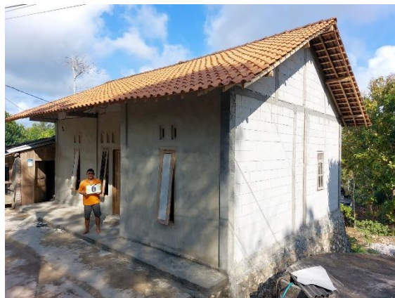
Gambar 3.58 Dokumentasi Hasil Pekerjaan Infrastruktur Perumahan dan Permukiman
